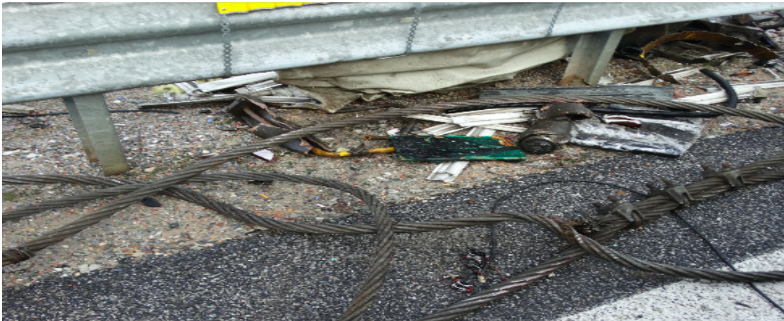
Εικόνα Συρματόσχοινα στον τόπο του συμβάντος που έχουν αποκοπεί λόγω της σφοδρότητας της σύγκρουσης
